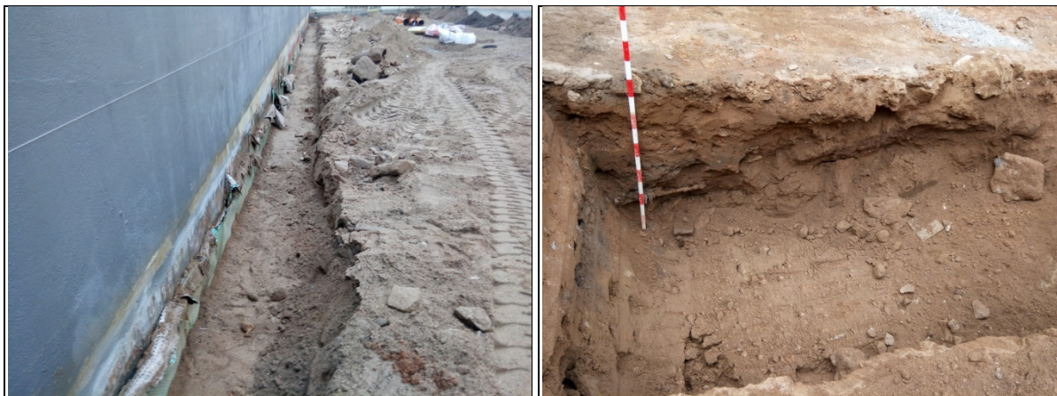
A l'esquerra, vista general de la rasa de sanejament situada a la vessant oest de la finca. A la dreta, detall d'una de les rases corresponents a l'arbrat previst en el projecte d'obra.
