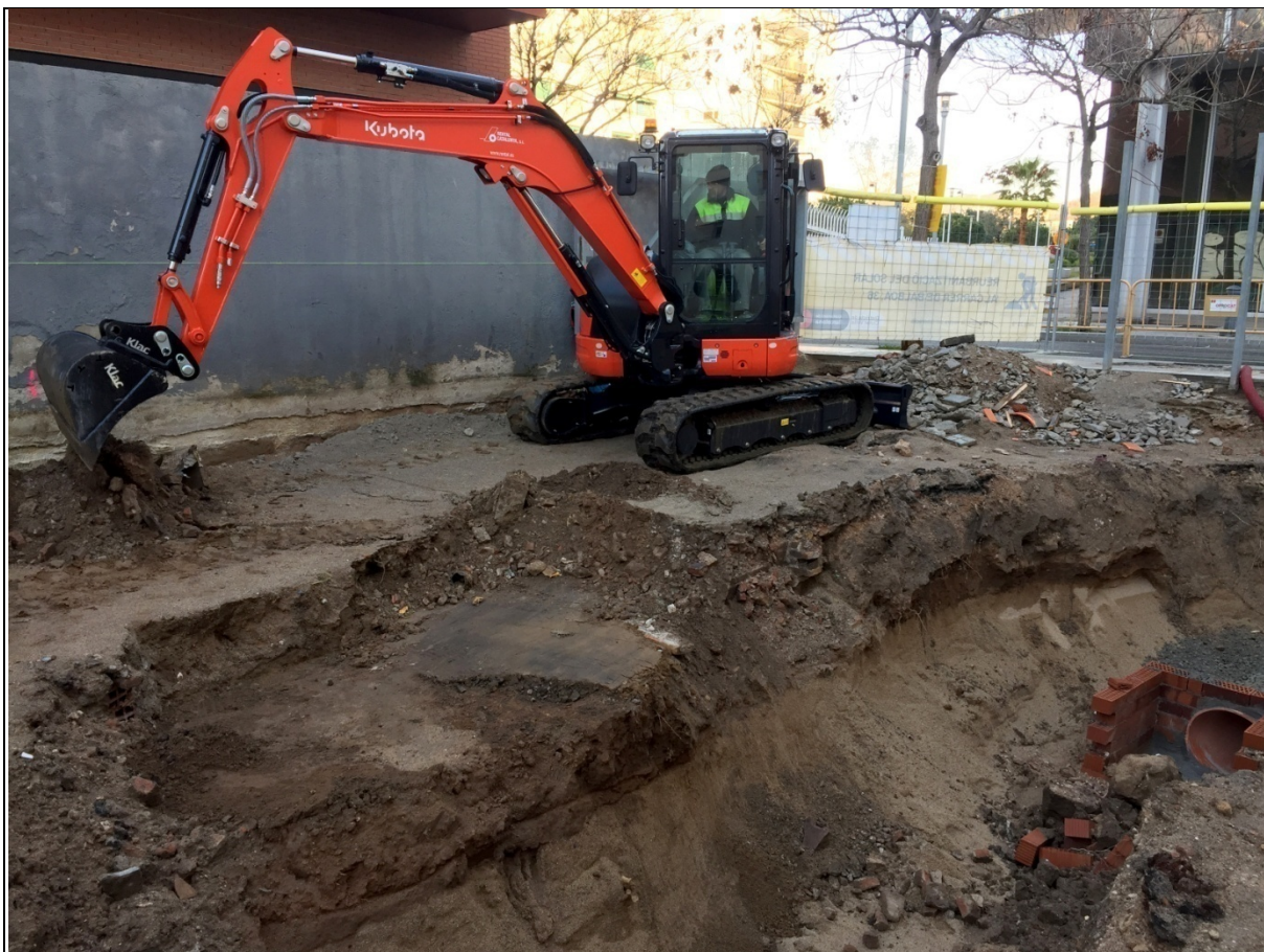
Vista dels treballs de rebaix efectuats amb maquinària.
