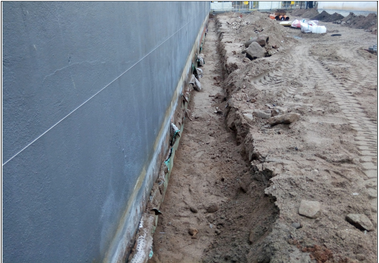
FOTO 13. Vista de la rasa perimetral R11.
